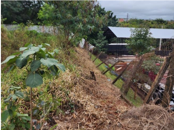
Foto 06 – Extremidade do terreno. Talude na divisa do terreno vizinho.
