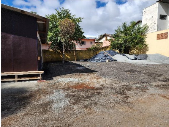
Foto 07 – Armazenamento de Materiais.
