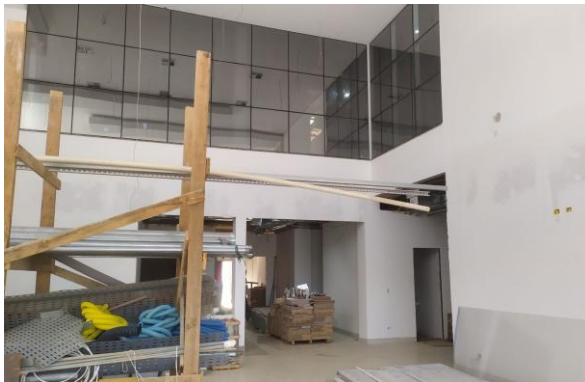
Foto 01 – Entrada primeiro pavimento.
