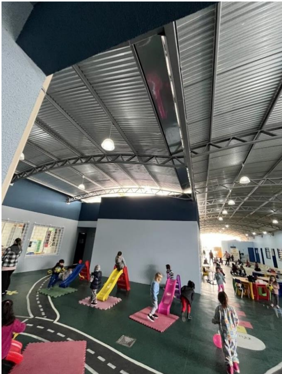
Foto 08 – Pátio com cobertura metálica
