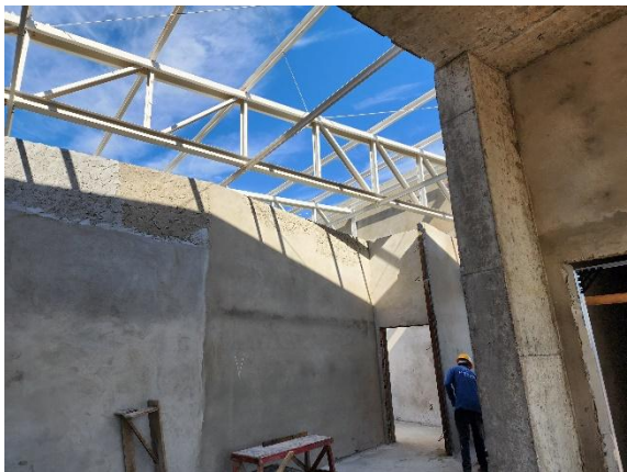
Foto 03 – Último pavimento da edificação, cobertura.
