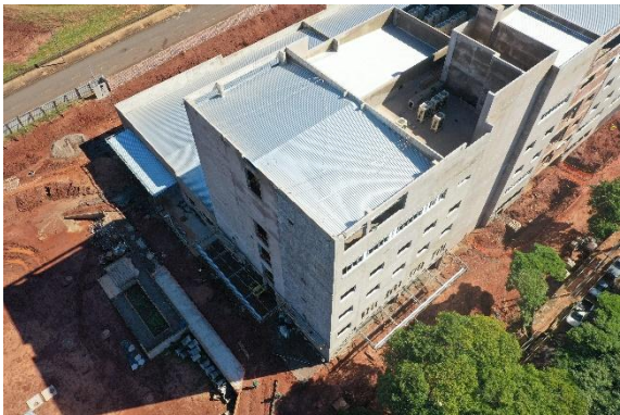
Foto 04 – Vista Aérea: Fachadas e Cobertura
