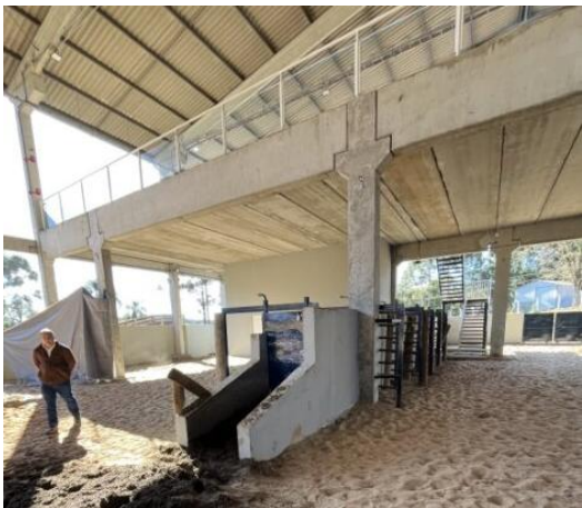
Foto 06 – Estrutura pré-moldada da Arena Cultural.
