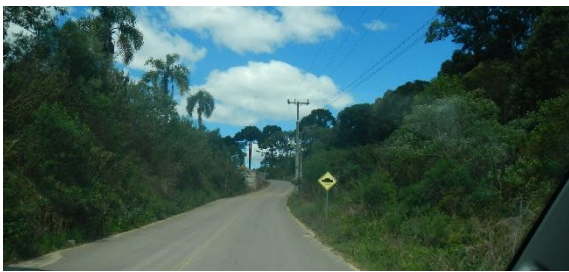
Foto 02 – Pavimentação e Sinalização.
