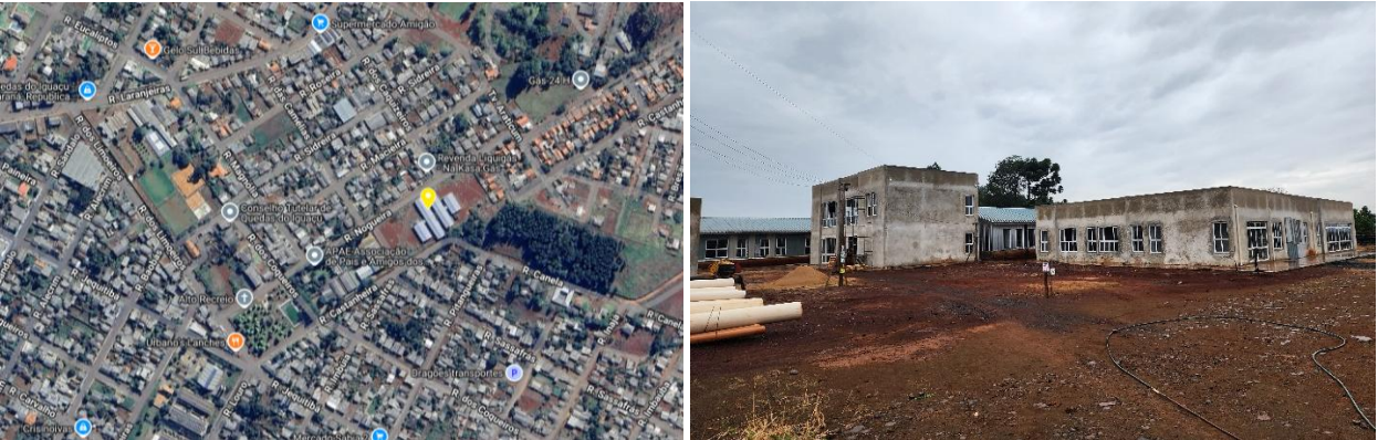
FIGURA 1 - Localização obra e foto geral da obra
