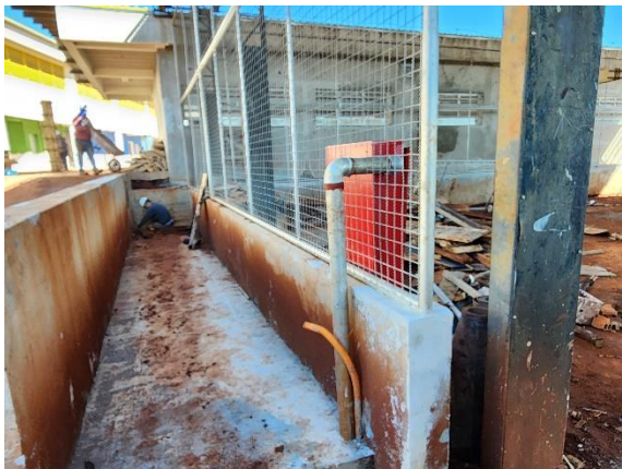
Foto 05 – Corredor. Serviços em execução.
