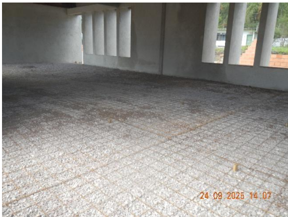
Foto 05 – Execução de Piso.
