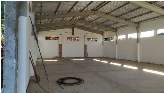
Foto 04 – Vista interna da obra, fundo e lado direito.
