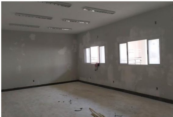
Foto 05 – Sala de aula
