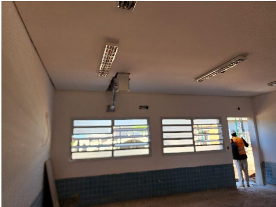
Foto 07 – Sala de aula em execução.
