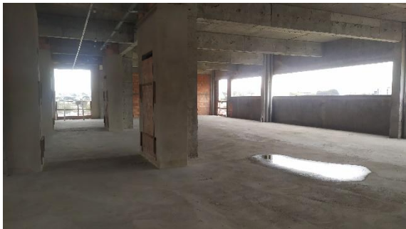
Foto 05 – Visão geral do pavimento (Bloco A)
