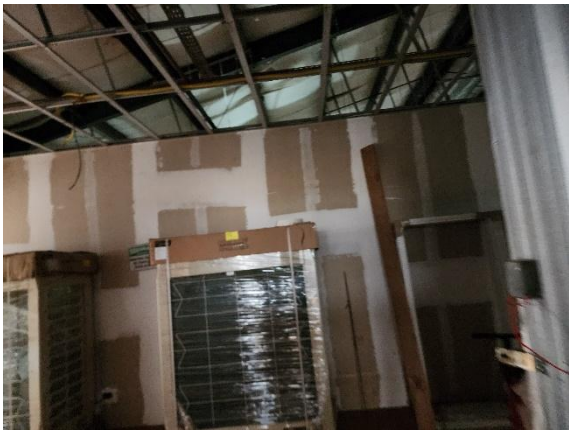
Foto 02 – Aparelhos de ar condicionado a serem instalados, dry wall executado.
