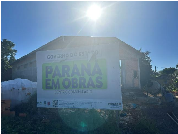
Foto 01 – Placa da obra.
