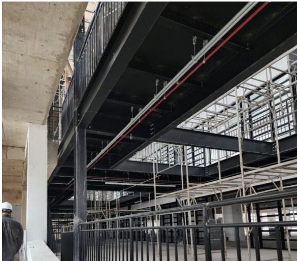
Foto 07 – Estrutura metálica e de concreto.
