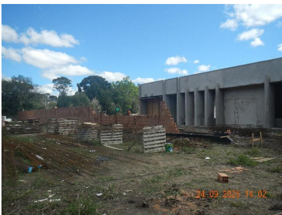
Foto 02 – Execução de Muro de Divisa.
