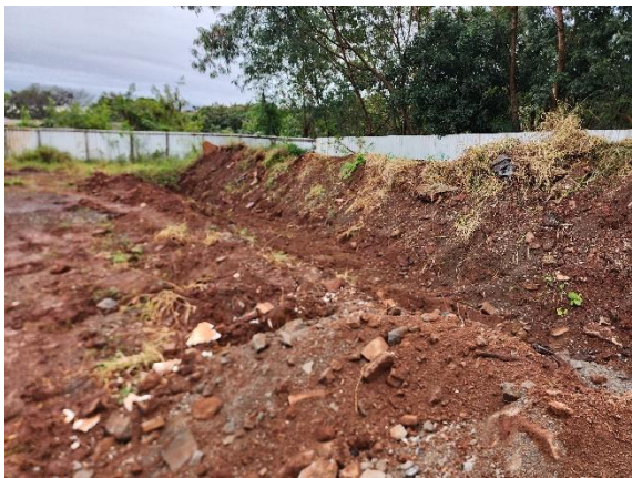
Foto 01 – Vala para demonstração do aterro existente.
