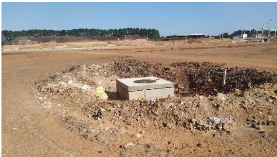
Foto 04 – Caixa de drenagem pronta
