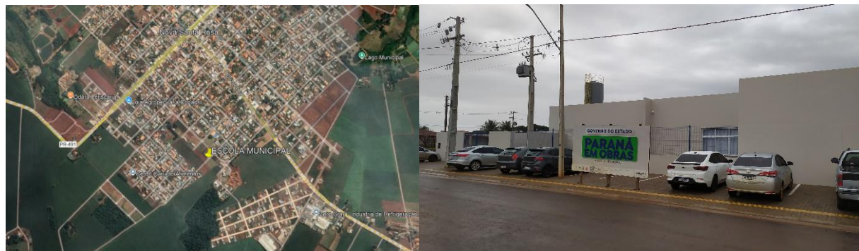
FIGURA 1 - Localização obra e foto geral da obra
