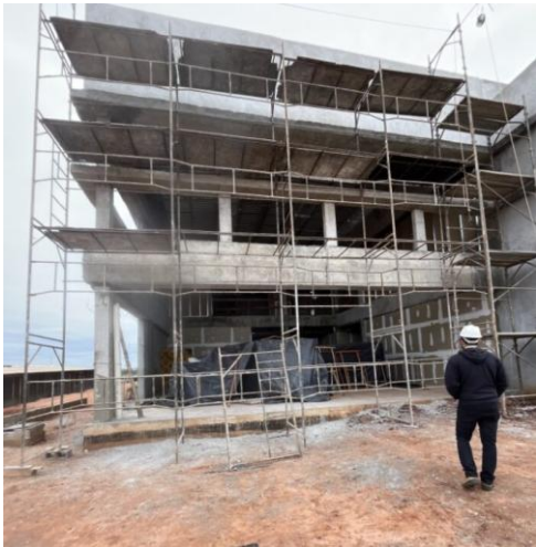
Foto 08 – Andaimes da fachada.
