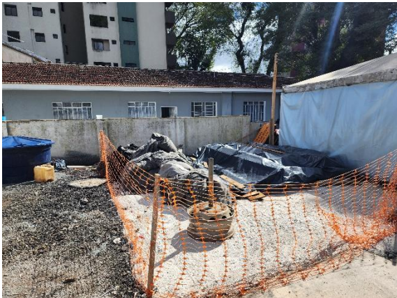
Foto 06 – Armazenamento de Materiais.
