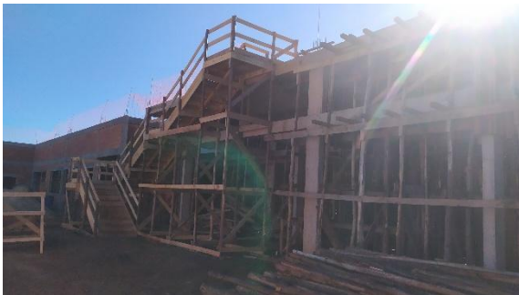
Foto 10 – Vista da estrutura e escoramentos.
