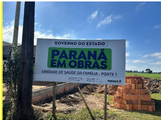
Foto 01 – Placa da obra
