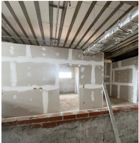
Foto 07 – Execução dos fechamentos drywall.
