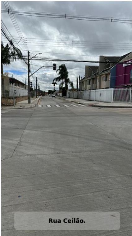
Foto 01 – Pavimentação Rua Ceilão.
