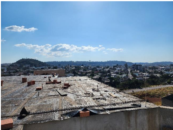
Foto 06 – Heliponto na edificação.
