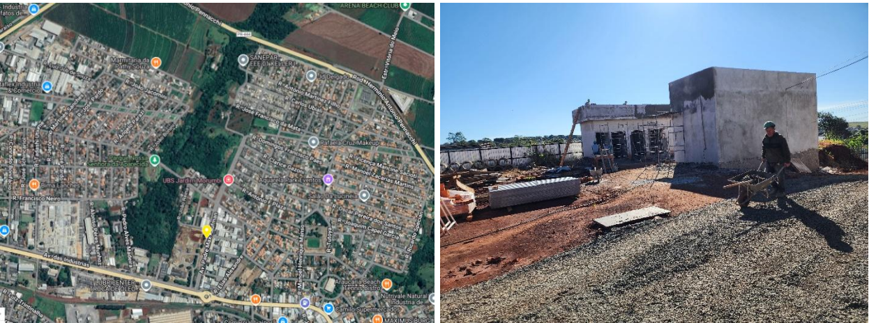
FIGURA 1 - Localização obra e foto geral da obra
