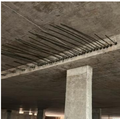
Foto 01 – Estrutura de concreto.
