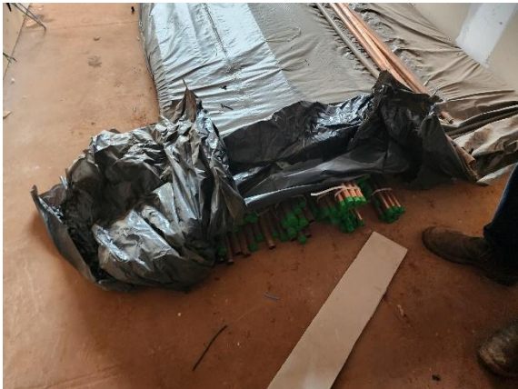
Foto 05 – Cobre para instalação da infraestrutura do ar-condicionado.
