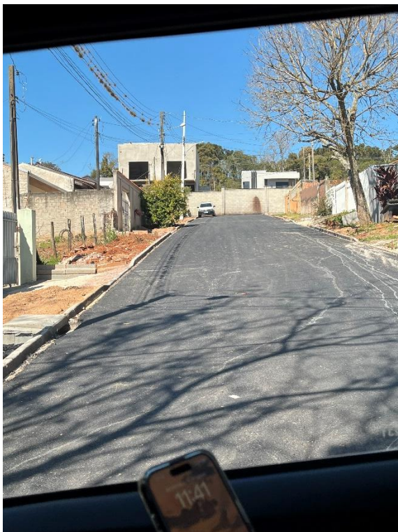
Foto 03 – Pavimentação em CBUQ, Rua Eduardo Levandoski Filho.
