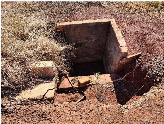
Foto 03 – Serviços de drenagem.
