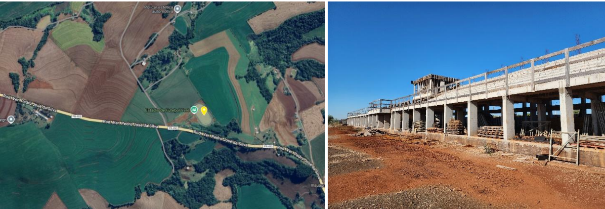
FIGURA 1 - Localização obra e foto geral da obra
