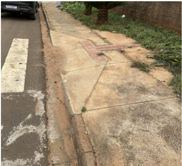
Foto 02 – Rampa de acessibilidade.
