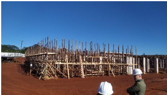
Foto 03 – Vista das escoras e formas.
