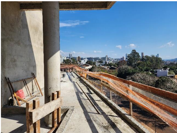
Foto 02 – Vista da obra.
