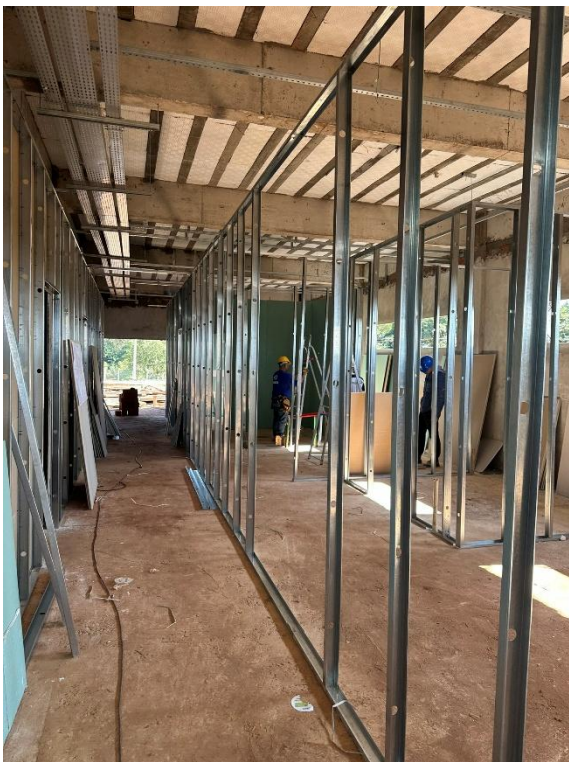
Foto 06 – Execução de drywall
