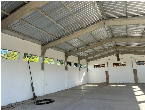
Foto 06 – Vista interna da obra, fundo e lado esquerdo.
