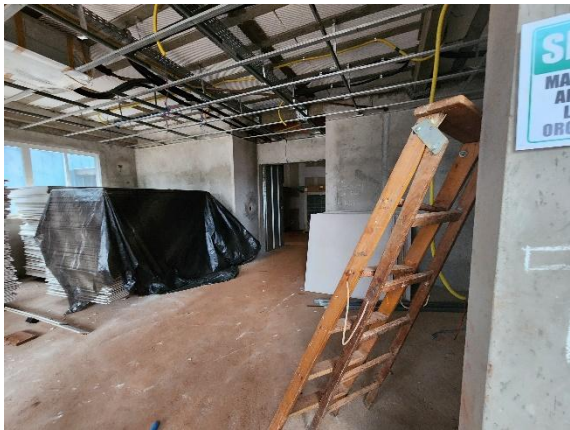
Foto 01 – Forro em execução.
