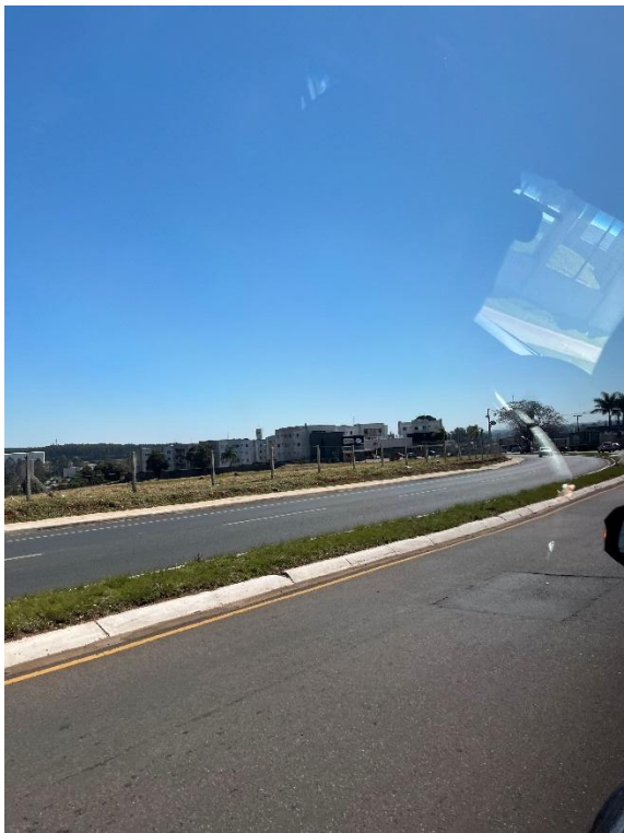
Foto 01 – Pavimentação em CBUQ, Rua Valério Ronchi.
