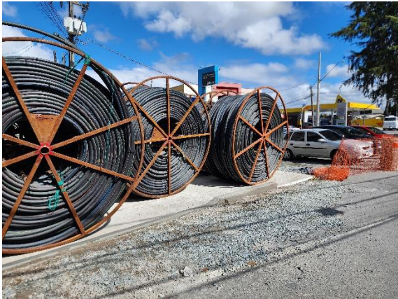
Foto 04 – Armazenamento de Materiais.
