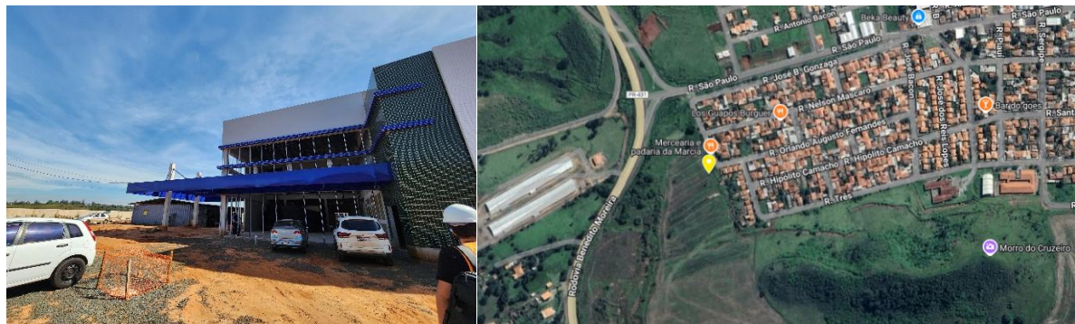
FIGURA 1 - Localização obra e foto geral da obra
