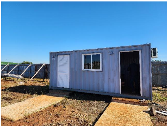
Foto 03 – Escritório do Canteiro – Depredado.
