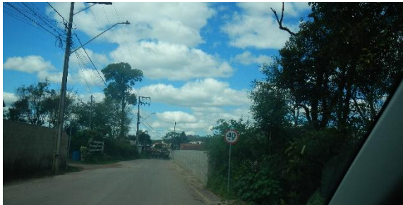
Foto 05 – Pavimentação e Sinalização.
