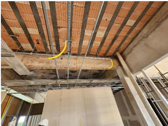
Foto 02 – Laje e parede de dry-wall.
