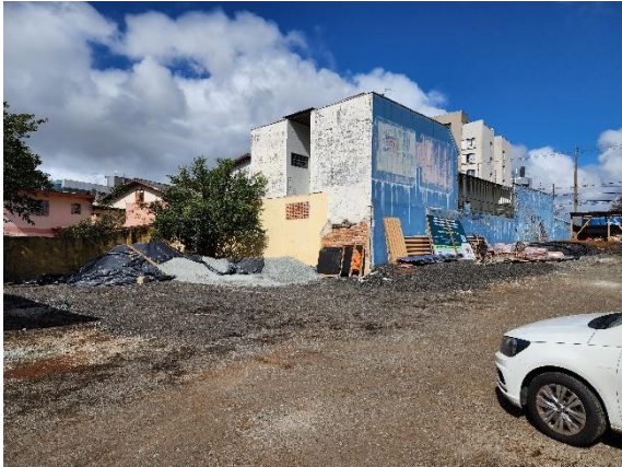
Foto 08 – Armazenamento de Materiais.
