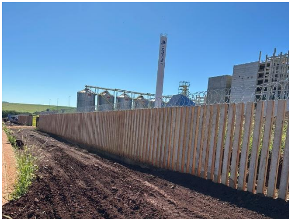
Foto 01 – Muro Palito.
