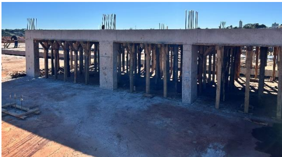
Foto 14 – Vista da área superior da laje edificada.
