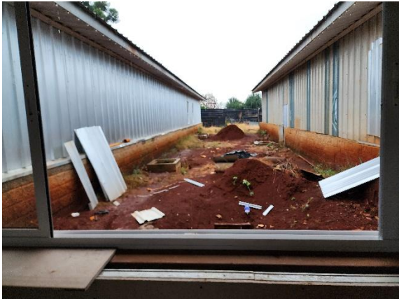
Foto 03 – Local entre 2 blocos.
