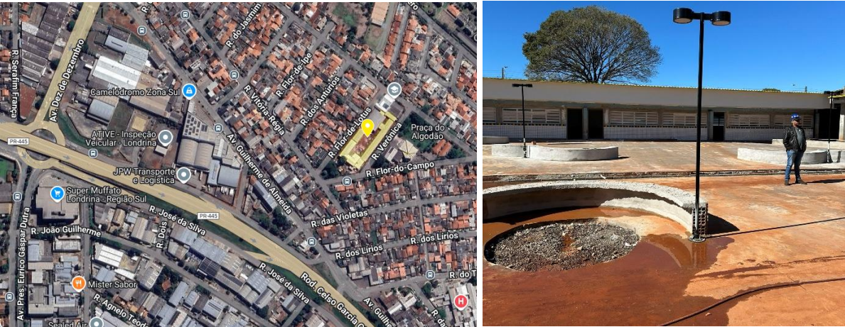
FIGURA 1 - Localização obra e foto geral da obra
