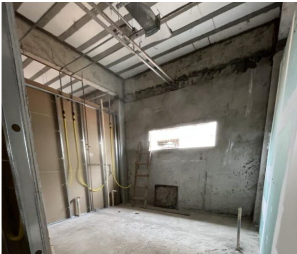
Foto 02 – Fechamento em drywall.
