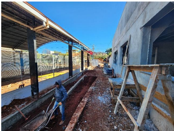
Foto 05 – Serviços em execução.
