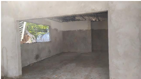
Foto 05 – Almoxarifado, depósito e sala multiuso
