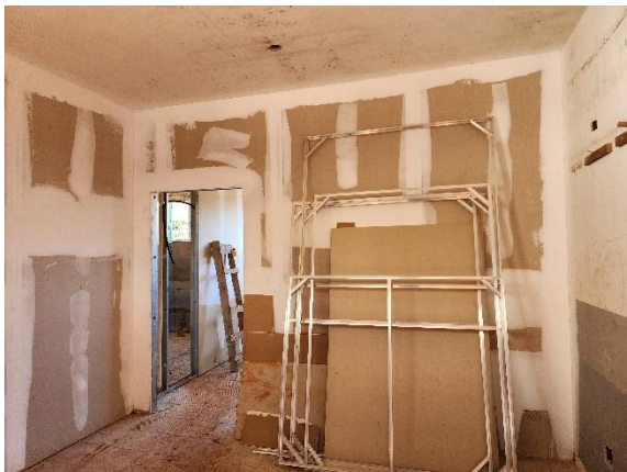
Foto 03 – Serviços em execução.
