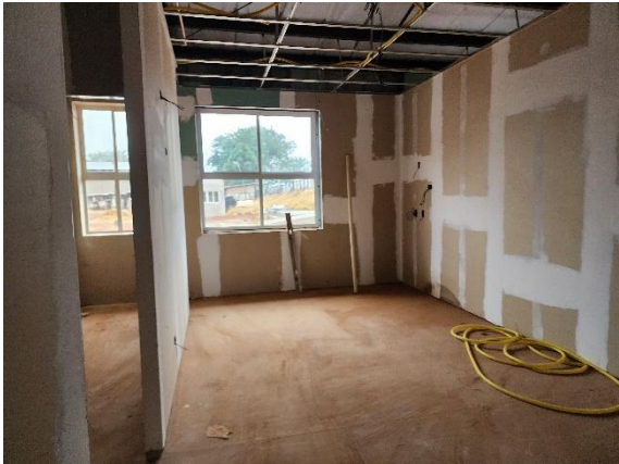
Foto 04 – Sala em execução, já com esquadrias.
