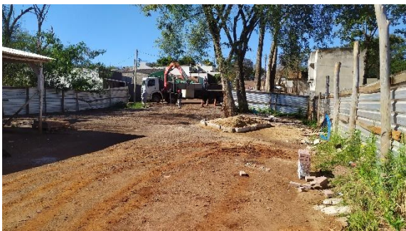
Foto 04 – Canteiro sendo desmobilizado
