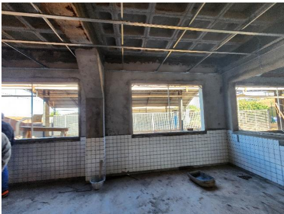
Foto 04 – Revestimento executado. Laje cogumelo.
