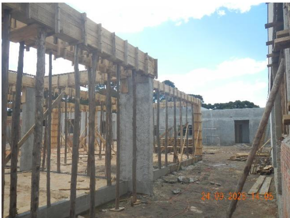
Foto 04 – Execução de Estrutura.
