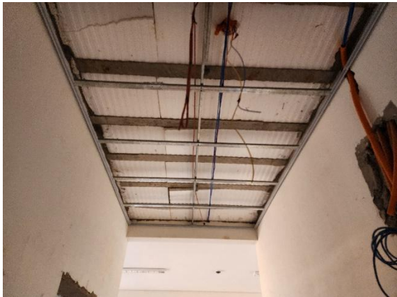
Foto 03 – Forro em execução.
