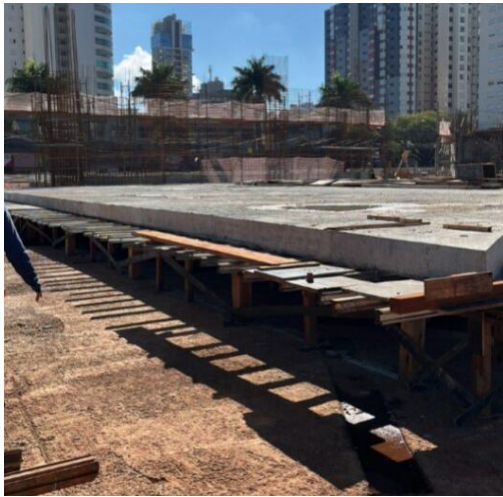
Foto 07 – Laje de concreto.
