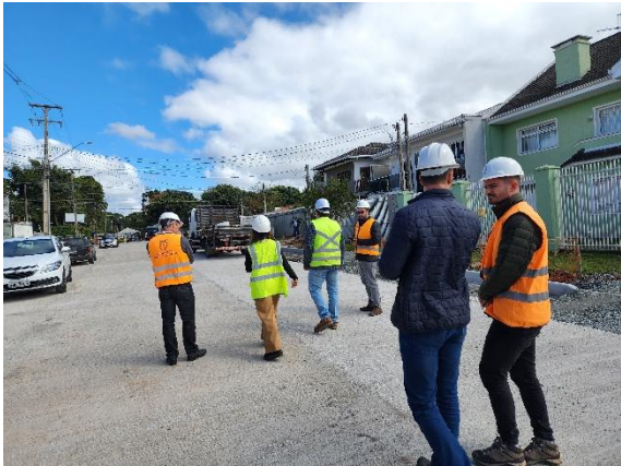
Foto 03 – Vistoria de Obra.
