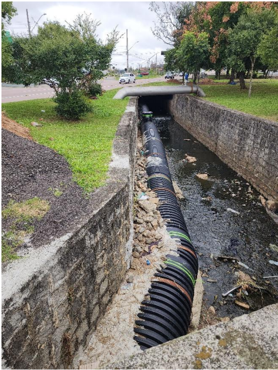
Foto 04 – Condutos Forçados.
