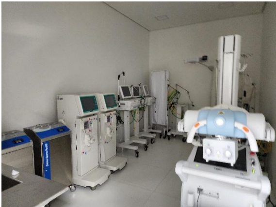
Foto 06 – Equipamentos em espera para instalação.
