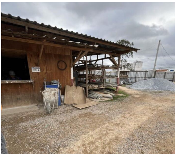
Foto 03 – Canteiro de obras e armazenamento.
