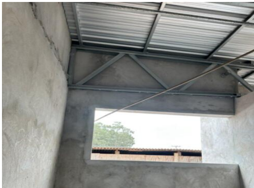
Foto 08 – Requadro para instalação das esquadrias
