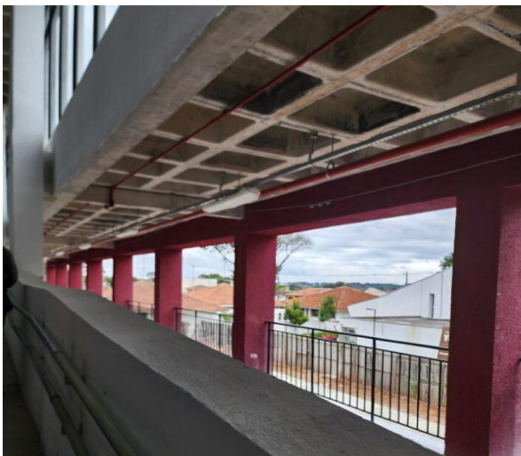
Foto 06 – Laje nervurada.
