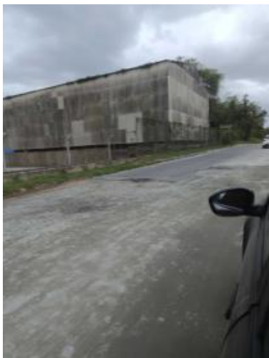
Foto 05 – Início do trecho pavimentado pela prefeitura
