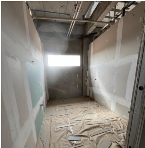
Foto 05 – Fechamentos em drywall
