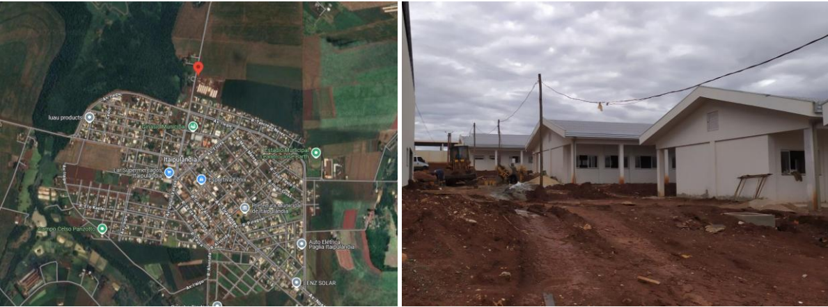
FIGURA 1 - Localização e foto geral da obra
