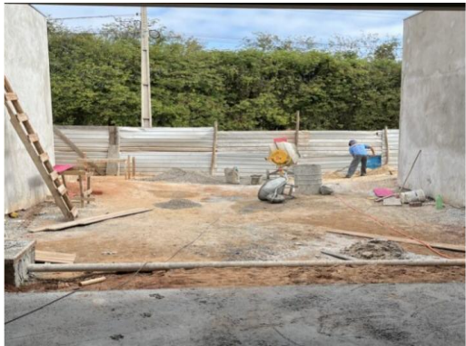
Foto 02 – Frente de trabalho.
