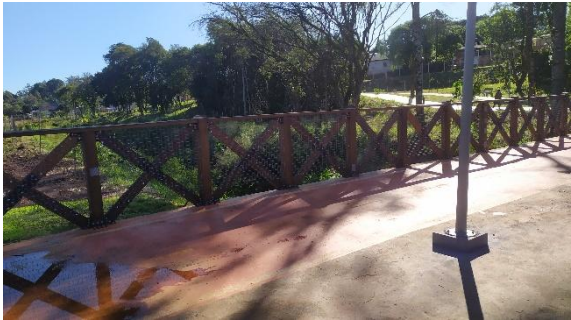
Foto 10 – Pontilhão em concreto armado.
