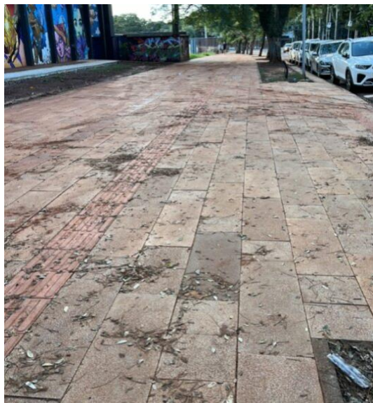
Foto 02 – Piso em placas de concreto.
