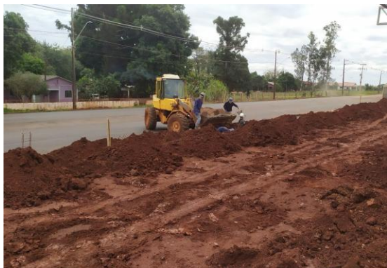
Foto 02 – Serviços de drenagem no acesso.
