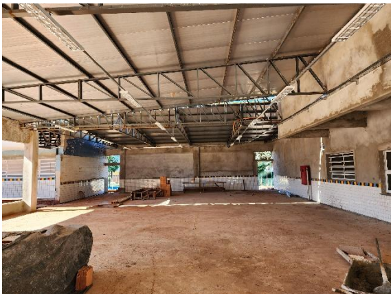
Foto 06 – Revestimentos já executados.
