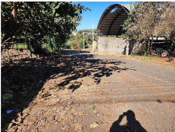
Foto 04 – Final de uma das ruas pavimentadas.
