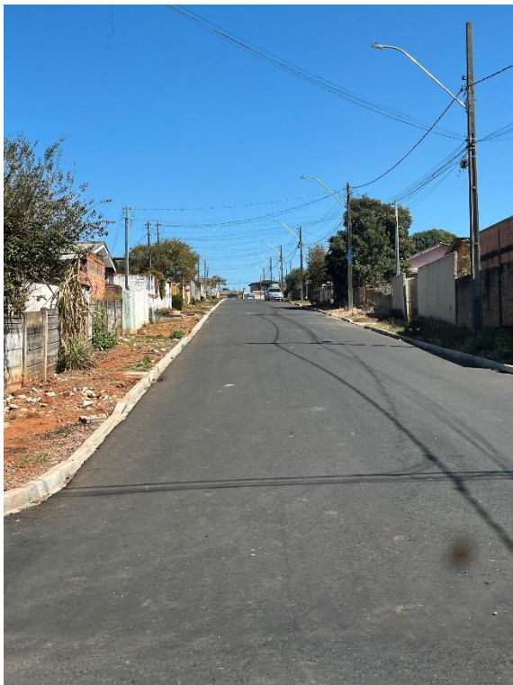
Foto 05 – Pavimentação em CBUQ, Rua Tembés.
