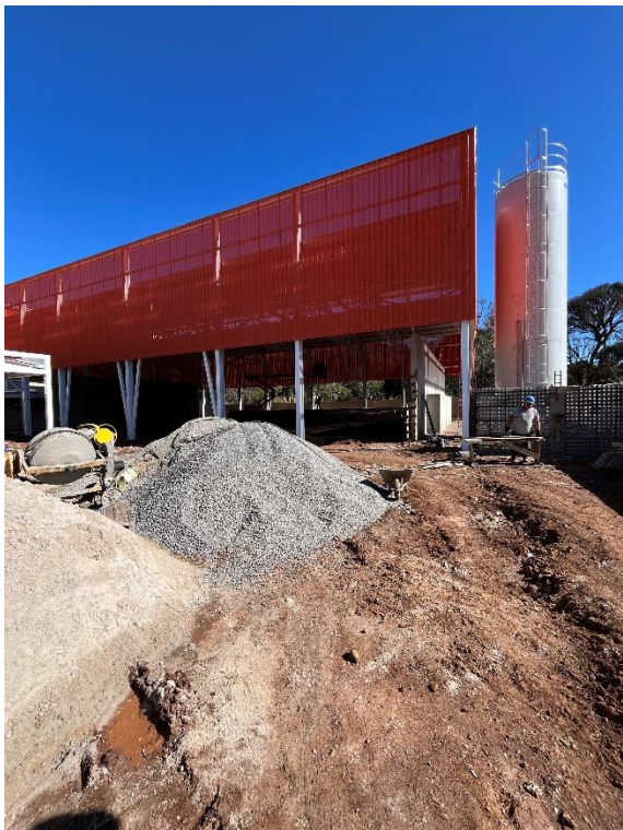
Foto 01 – Fachada da Quadra de Esportes
