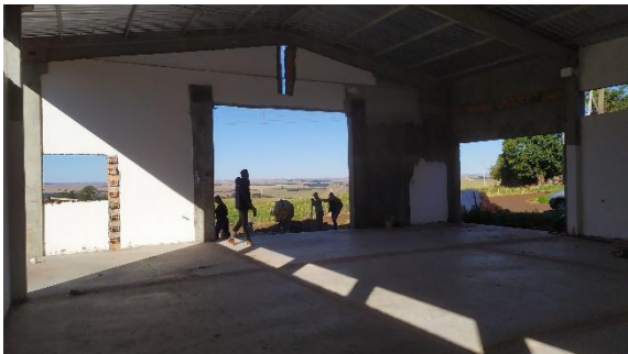
Foto 03 – Vista interna da fachada.
