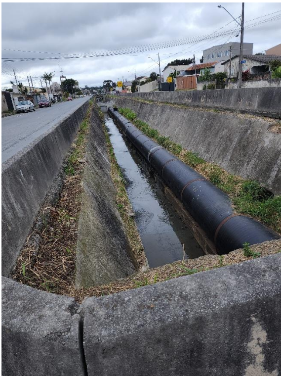
Foto 02 – Condutos Forçados.
