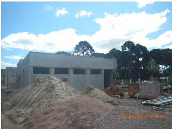
Foto 03 – Armazenamento de Materiais.
