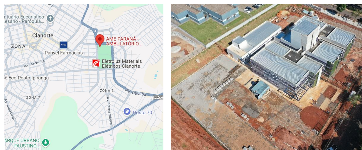
FIGURA 1 - Localização obra e foto geral da obra
