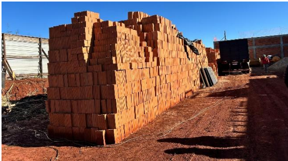
Foto 13 – Armazenamento dos blocos cerâmicos.
