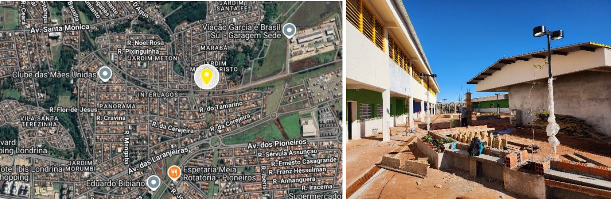
FIGURA 1 - Localização obra e foto geral da obra
