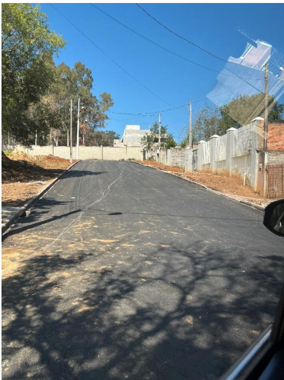
Foto 04 – Pavimentação em CBUQ, Rua Dez.
