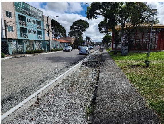
Foto 01 – Pavimentação e Calçada de Pedestres.
