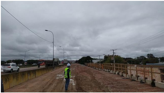
Foto 06 – Execução da pavimentação.
