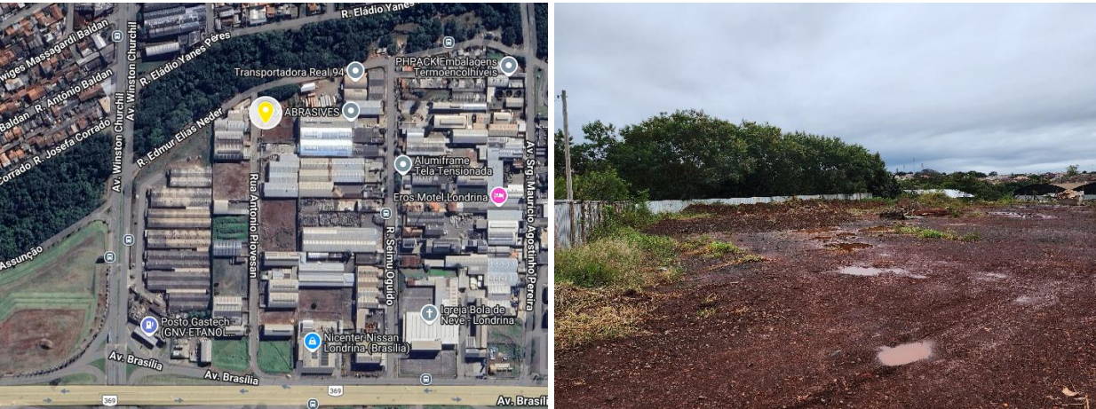
FIGURA 1 - Localização obra e foto geral da obra
