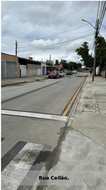
Foto 03 – Armazenamento Rua Ceilão.
