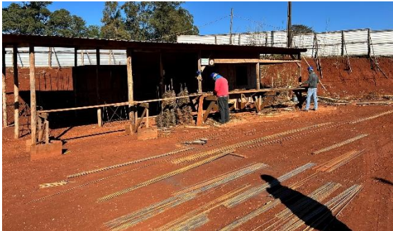
Foto 11 – Estação de montagem de armaduras.
