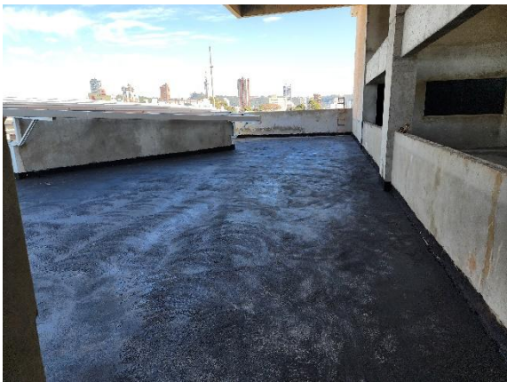
Foto 04 – Serviços de impermeabilização executados.
