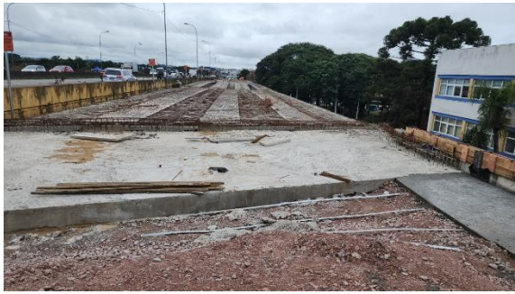
Foto 07 – Viaduto do Tarumã.
