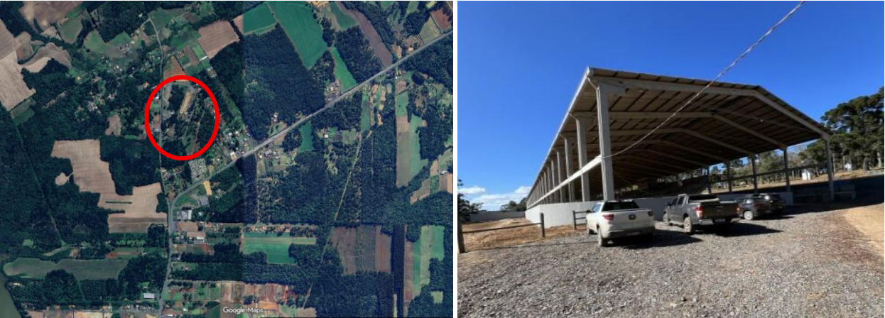
FIGURA 1 - Localização obra e foto geral da obra
