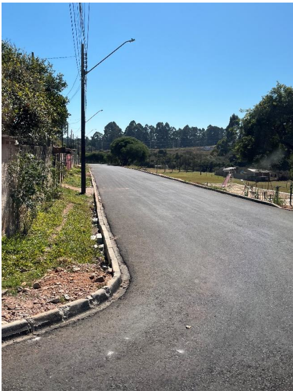
Foto 06 – Pavimentação em CBUQ, Rua Tapiuas.
