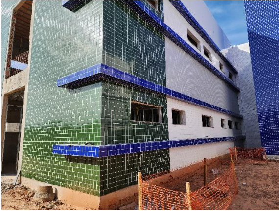
Foto 07 – Exterior da edificação.
