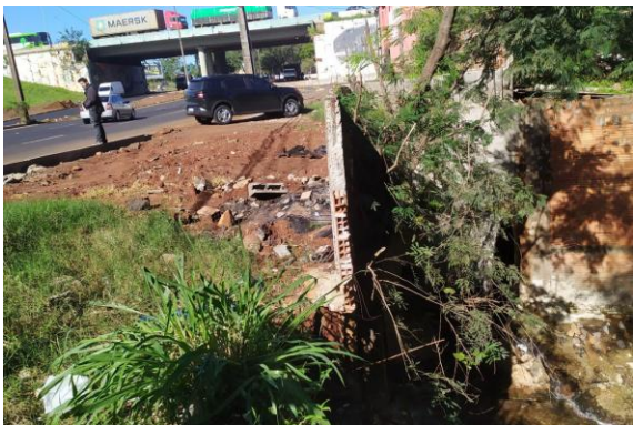
Foto 03 – Final do bueiro em PEAD.
