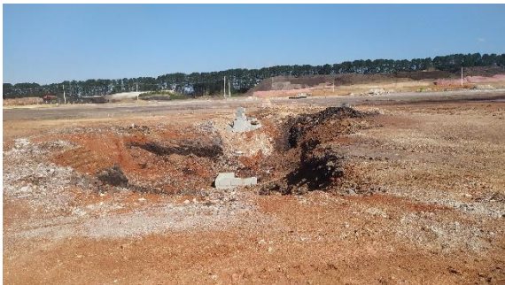
Foto 03 – Caixa de drenagem em execução
