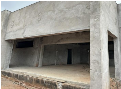
Foto 01 – Alvenaria externa.
