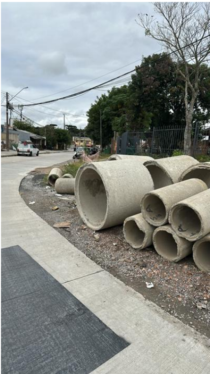
Foto 02 – Armazenamento de Materiais.
