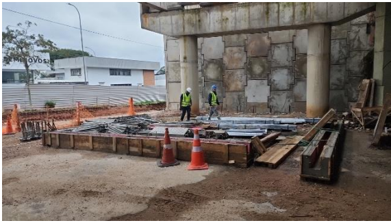
Foto 08 – Armazenamento de Materiais.
