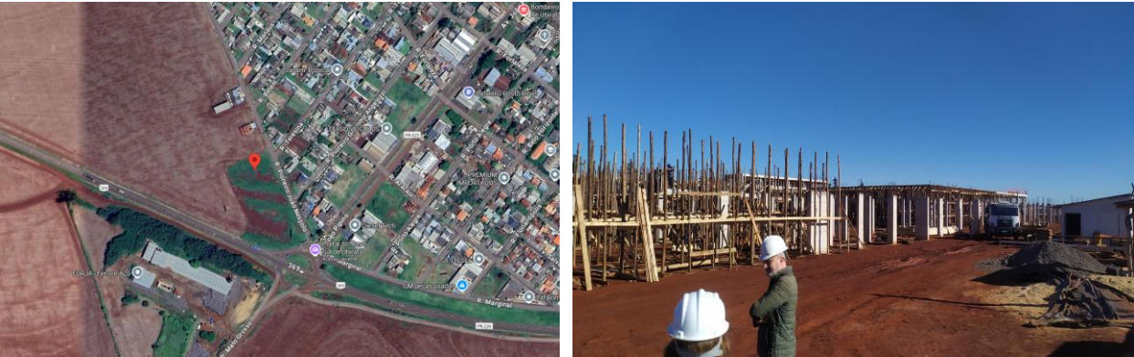
FIGURA 1 – Localização e foto geral da obra
