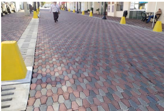
Foto 01 – Calçada em “paver”.
