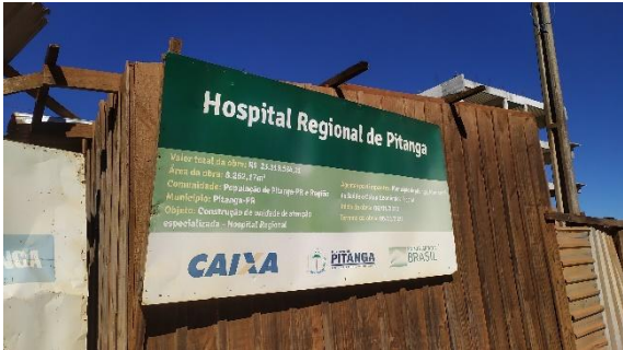
Foto 06 – Placa da obra
