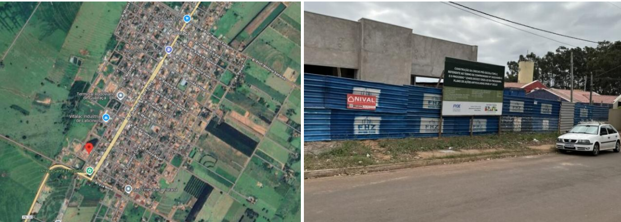
FIGURA 1 - Localização obra e foto geral da obra
