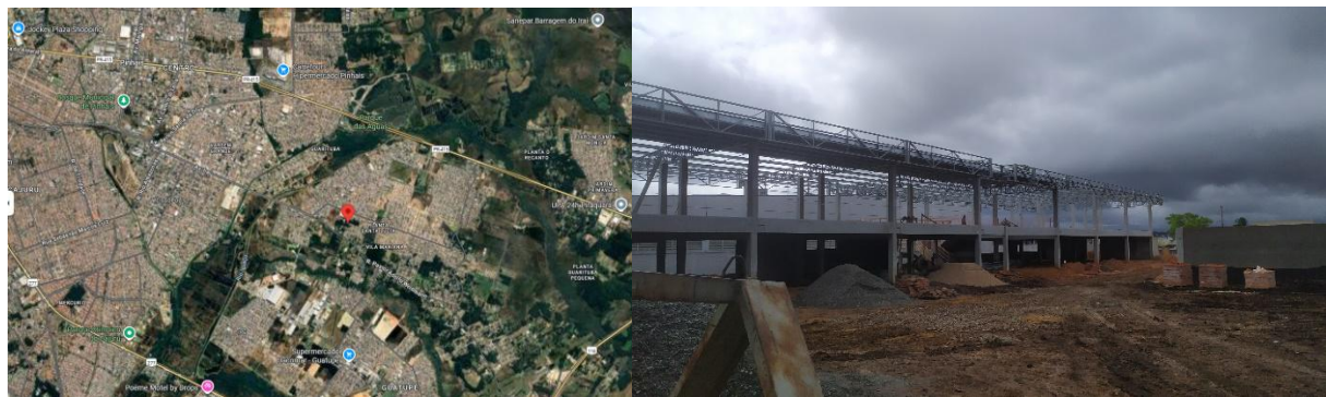
FIGURA 1 - Localização e foto geral da obra
