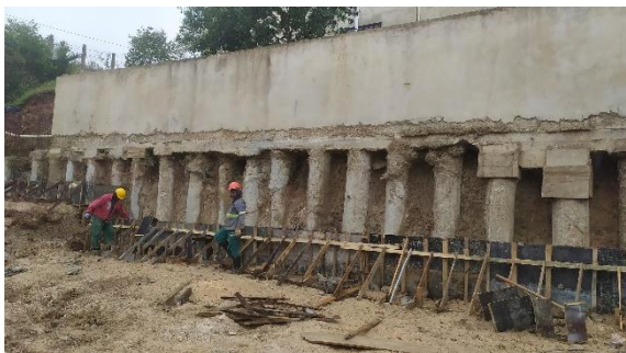
Foto 01 – Contenções do terreno
