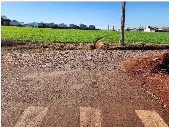
Foto 03 – Final de uma das ruas pavimentadas.
