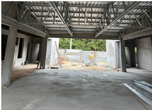
Foto 07 – Cobertura metálica e pisos internos
