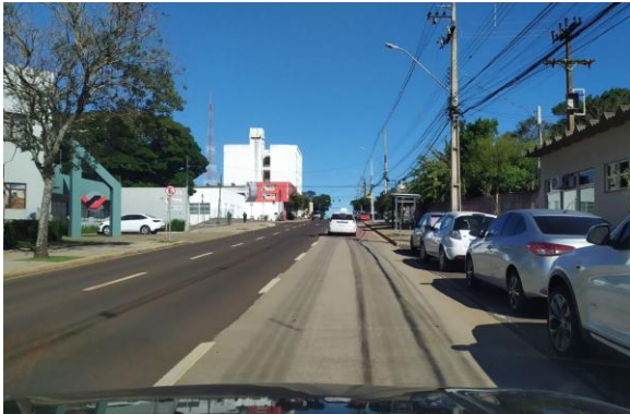
Foto 05 – Pista de ônibus em concreto.
