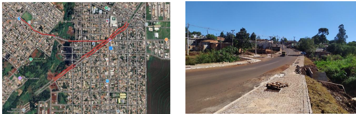
FIGURA 1 - Localização e foto geral da obra
