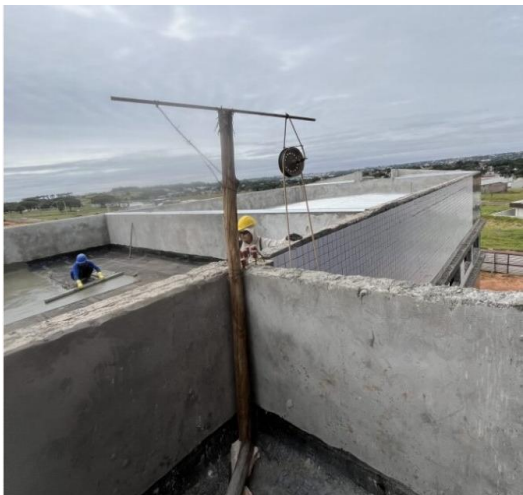
Foto 03 – Execução da impermeabilização na cobertura
