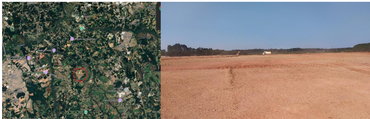
FIGURA 1 - Localização e foto geral da obra
