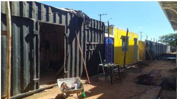
Foto 06 – Containers para depósito de ferramentas e refeitório
