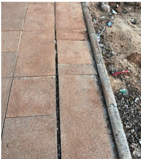
Foto 08 – Abertura de vão entre as placas trecho G.
