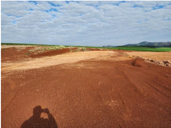
Foto 02 – Vista da obra.
