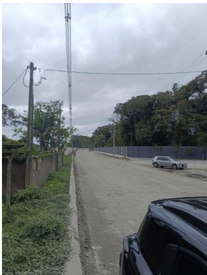
Foto 07 – Trecho com base
