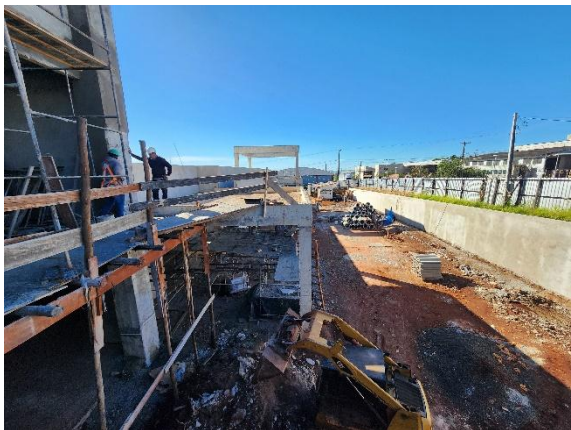
Foto 07 – Serviços em execução.
