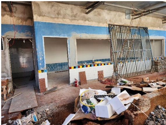
Foto 01 – Materiais no canteiro de obras.
