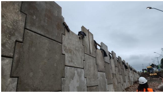
Foto 03 – Vista lateral do viaduto.
