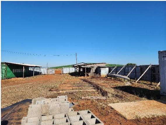
Foto 02 – Vista geral do canteiro de obras.
