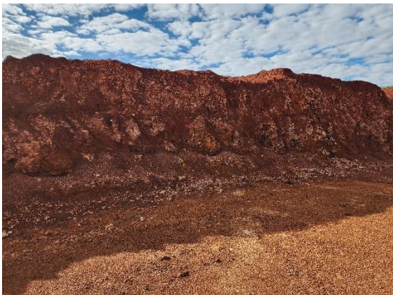
Foto 06 – Vista da obra.
