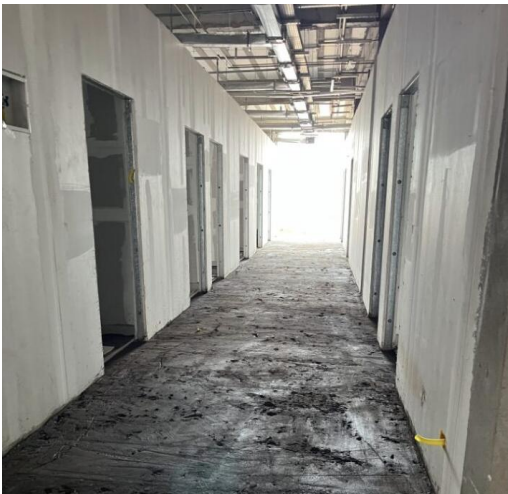
Foto 06 – Execução dos consultórios
