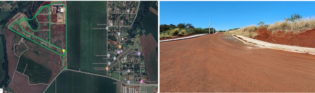
FIGURA 1 - Localização obra e foto geral da obra
