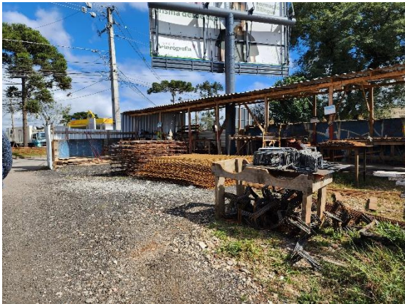
Foto 05 – Central de Aço.
