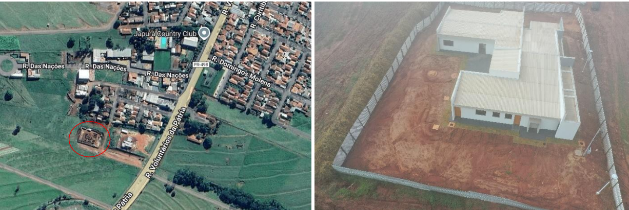
FIGURA 1 - Localização obra e foto geral da obra
