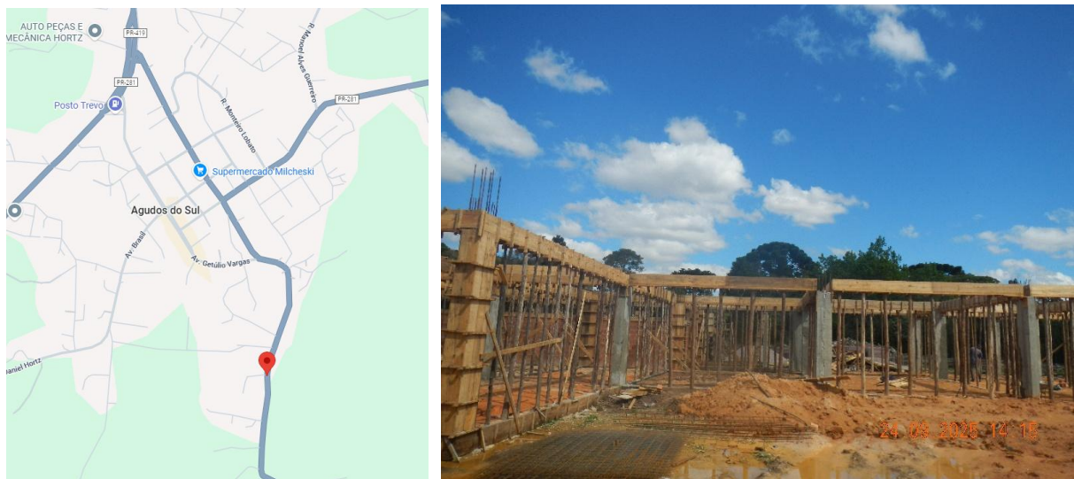
FIGURA 1 - Localização obra e foto geral da obra
