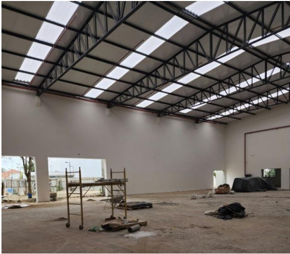
Foto 08 – Cobertura metálica.
