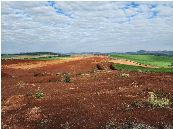
Foto 01 – Vista da obra.
