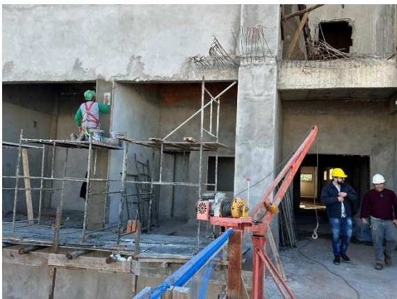
Foto 08 – Serviços em execução.
