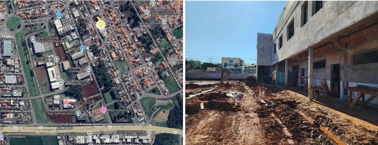
FIGURA 1 - Localização obra e foto geral da obra
