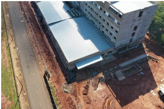
Foto 03 – Vista Aérea: Fachada Lateral e Cobertura
