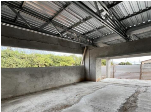
Foto 03 – Piso e cobertura metálica.
