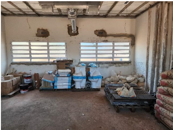
Foto 02 – Materiais armazenados, esquadrias e infraestrutura do ar condicionado instaladas.
