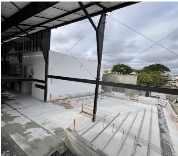
Foto 01 – Estrutura metálica e escadas externas.
