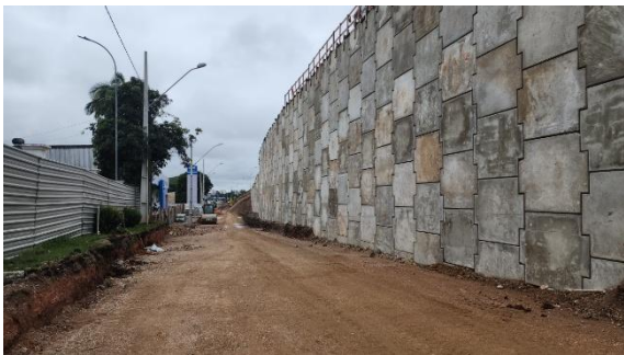
Foto 02 – Vista lateral do viaduto.
