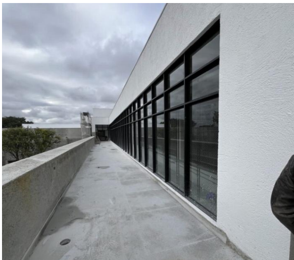
Foto 05 – Esquadrias de alumínio.
