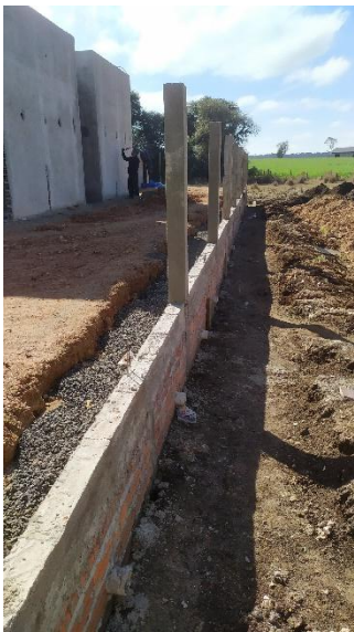
Foto 07 – Muro de arrimo e dreno
