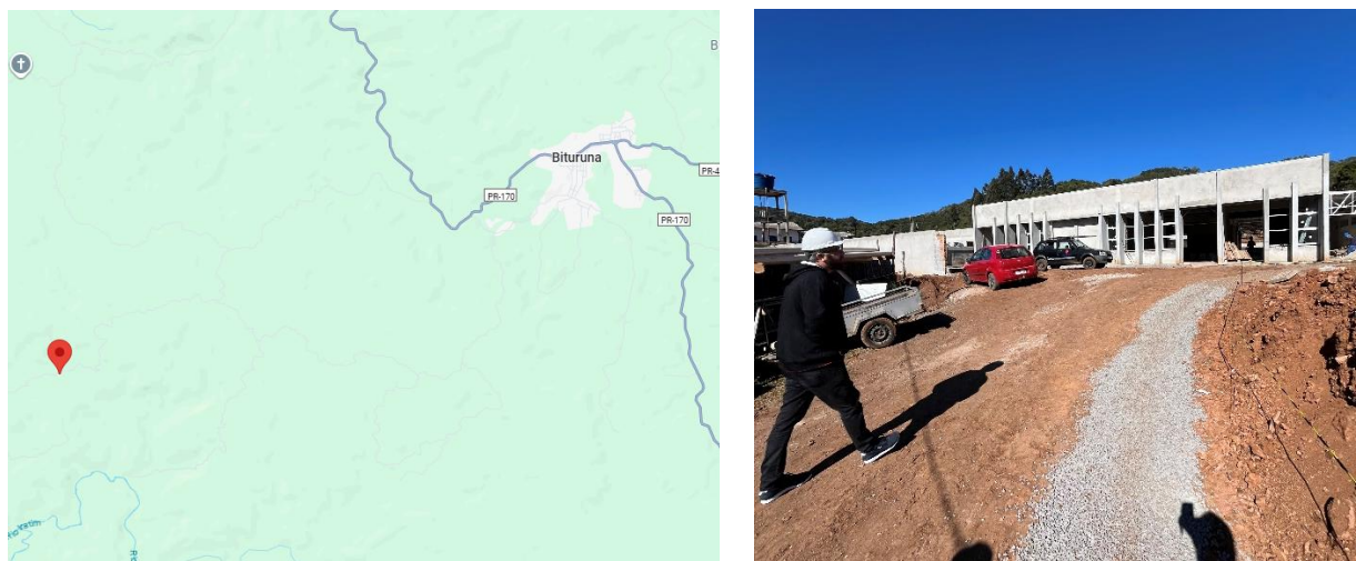
FIGURA 1 - Localização obra e foto geral da obra
