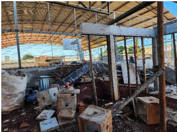
Foto 01 – Materiais armazenados no canteiro.
