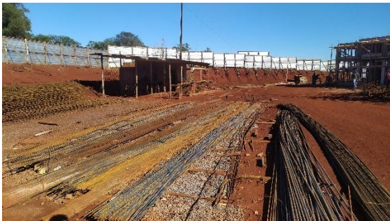
Foto 09 – Armazenamento das ferragens.
