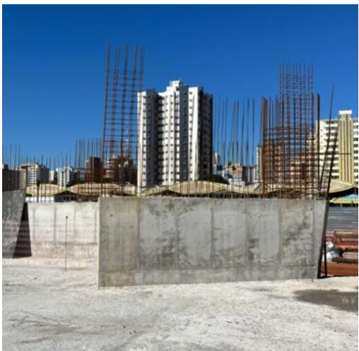
Foto 02 – Armaduras de aço.
