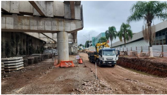
Foto 05 – Pilares e Vigas.
