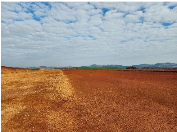
Foto 05 – Vista da obra.
