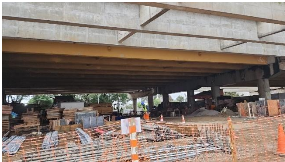
Foto 01 – Armazenamento de materiais.
