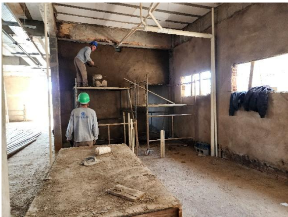
Foto 02 – Serviços em execução.
