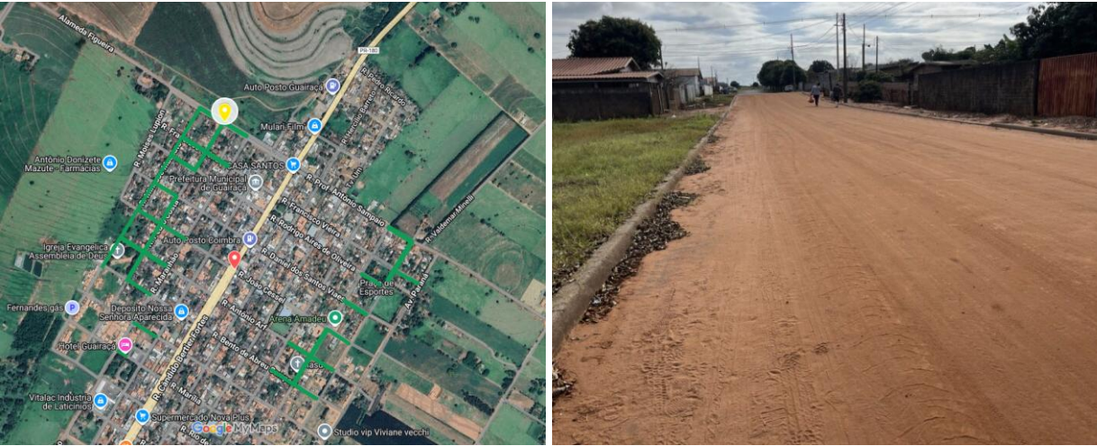
FIGURA 1 - Localização obra e foto geral da obra
