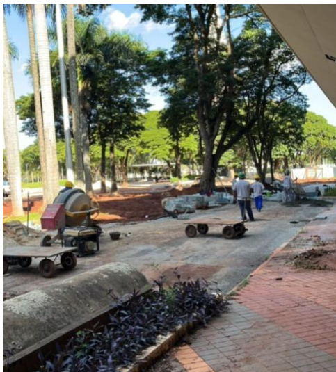
Foto 05 – Frente de serviços.
