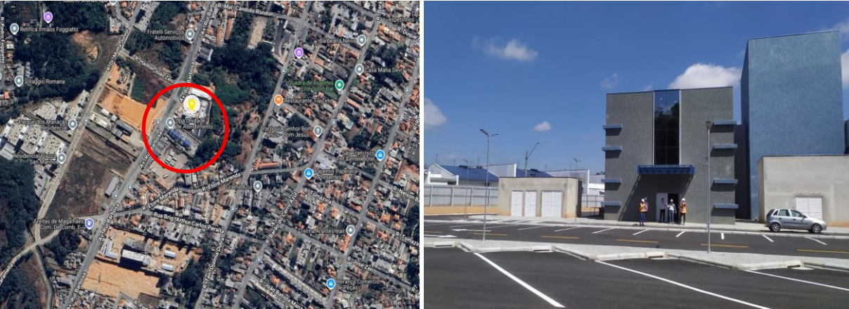
FIGURA 1 - Localização obra e foto geral da obra
