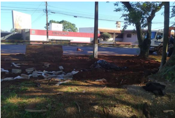
Foto 04 – Desmobilização canteiro de obra.
