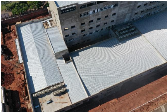
Foto 01 – Vista Aérea: Cobertura
