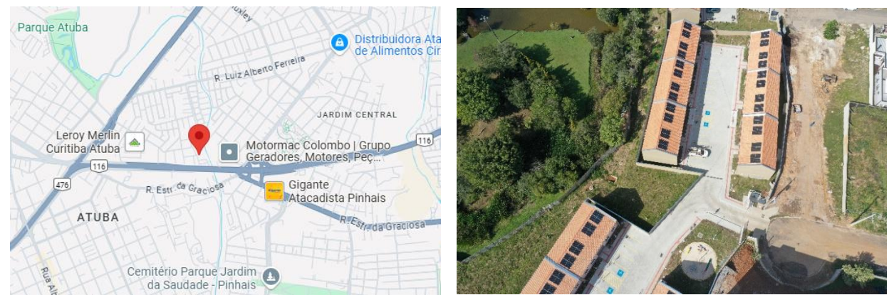
FIGURA 1 - Localização obra e foto geral da obra
