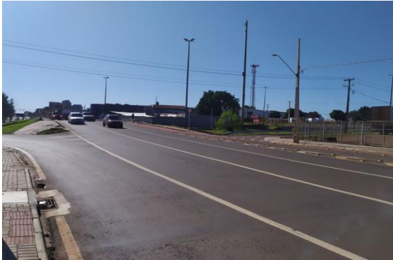
Foto 07 – Viaduto sobre a BR 277.
