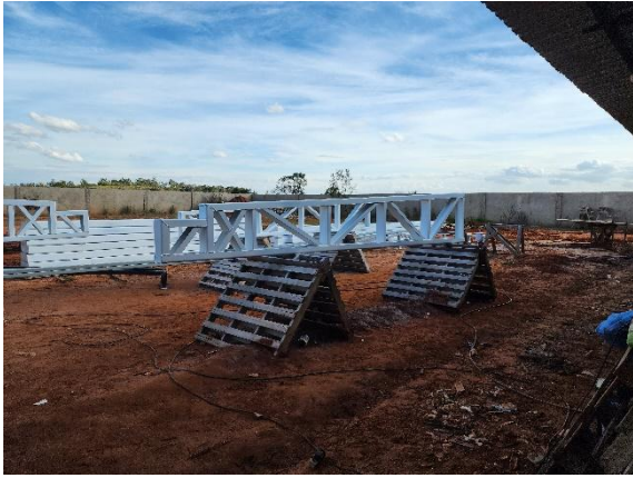
Foto 08 – Estrutura metálica da cobertura.
