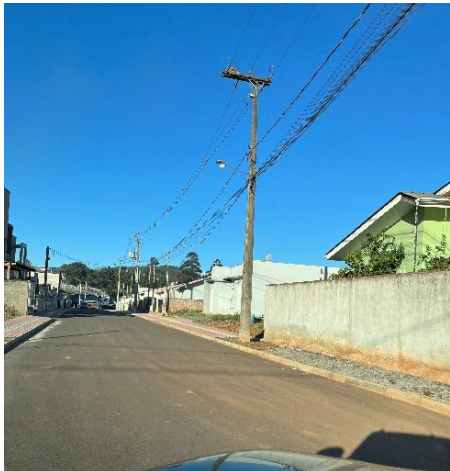
Foto 07 – Rua Heloísa de Paula Castilho; trecho de calçada sem paver
