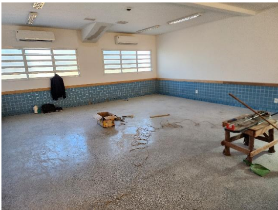
Foto 06 – Sala de aula. Piso em granilite.
