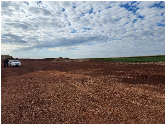
Foto 04 – Vista da obra.
