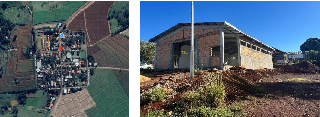
FIGURA 1 - Localização obra e foto geral da obra
