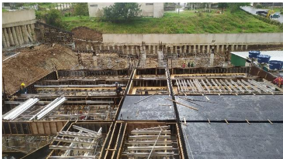
Foto 03 – Formas para concretagem do Bloco B
