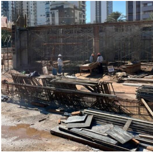
Foto 08 – Preparo das armaduras.
