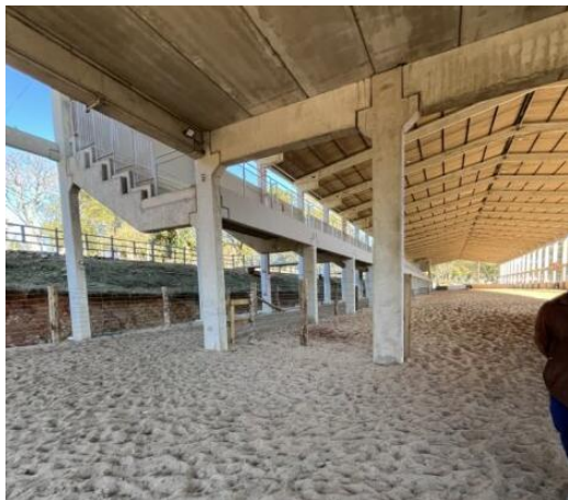
Foto 04 – Estrutura pré-moldada da Arena Cultural.
