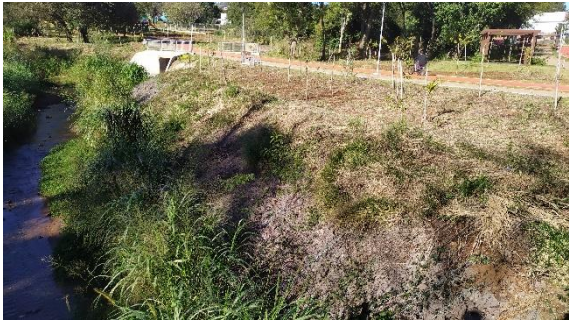
Foto 09 – Canalização de córrego com gabião. Ciclovía e pista de caminhada. Pontilhão com bueiro.
