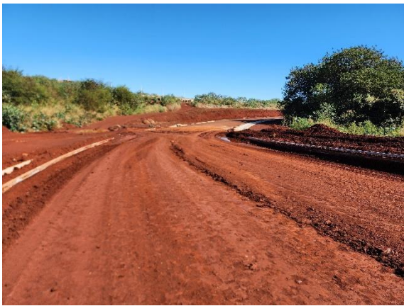
Foto 02 – Terraplenagem em execução.
