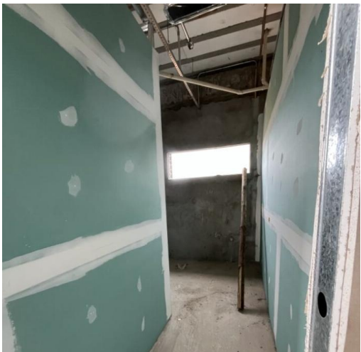
Foto 04 – Fechamento em drywall.
