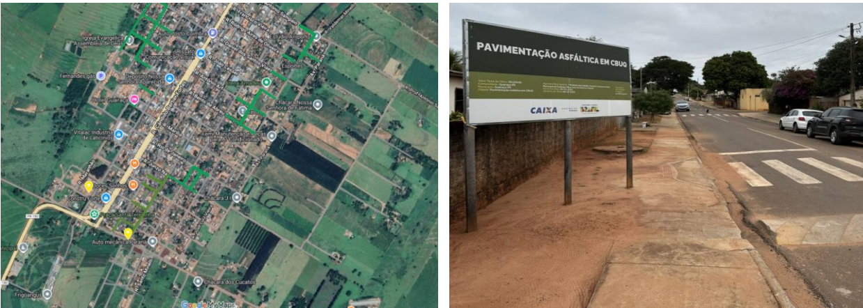
FIGURA 1 - Localização obra e foto geral da obra
