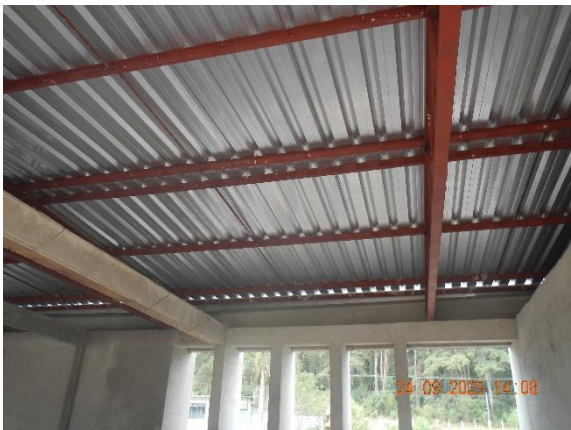
Foto 06 – Estrutura Metálica e Cobertura.
