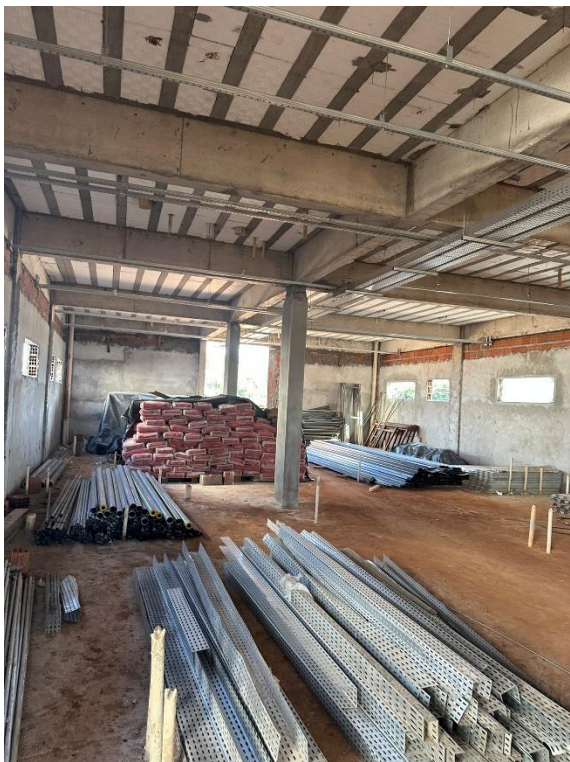
Foto 05 – Armazenamento de materiais
