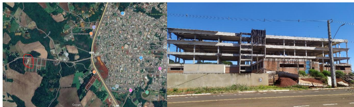
FIGURA 1 – Localização e foto geral da obra
