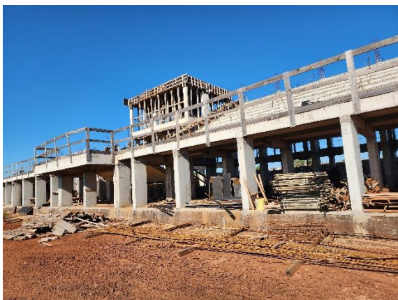
Foto 05 – Visão geral da arquibancada.
