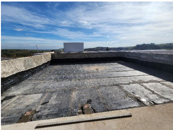
Foto 03 – Laje impermeabilizada.
