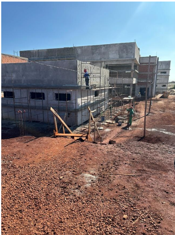
Foto 01 – Execução de Revestimento Bruto
