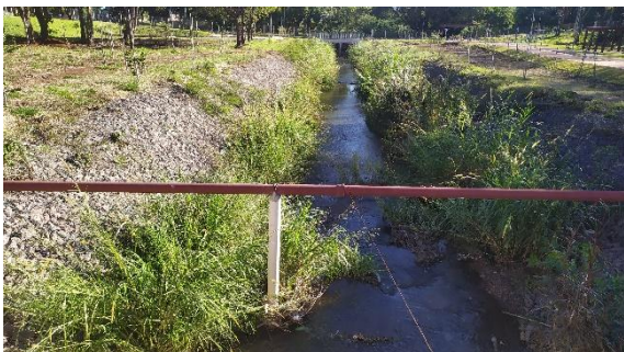
Foto 06 – Canalização de córrego com gabião
