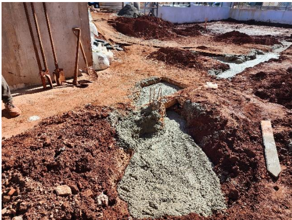
Foto 02 – Execução de concretagem de fundação.
