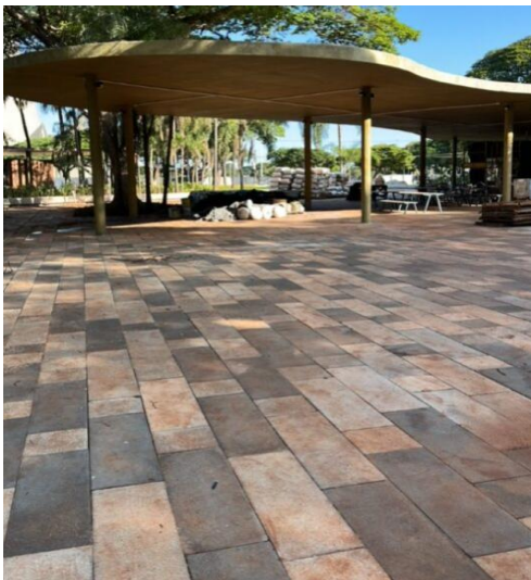
Foto 04 – Piso em placas de concreto Trecho B.
