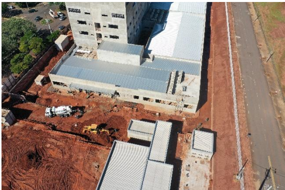
Foto 02 – Vista Aérea: Canteiro de Obras
