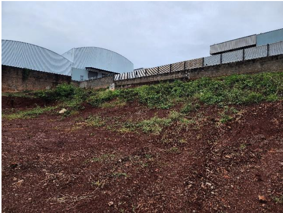
Foto 05 – Talude na divisa do terreno vizinho.
