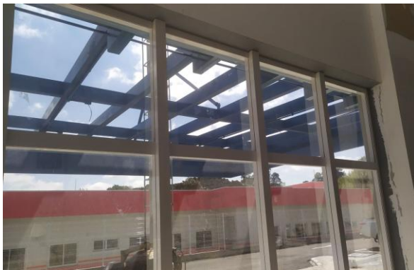
Foto 05 – Esquadrias de alumínio.
