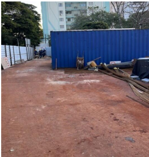
Foto 03 – Canteiro de obras.
