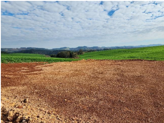
Foto 03 – Vista da obra.
