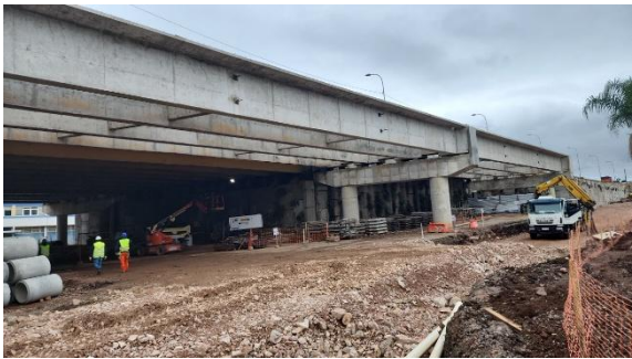
Foto 04 – Viaduto do Tarumã.
