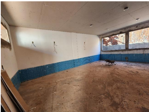
Foto 06 – Sala de aula.
