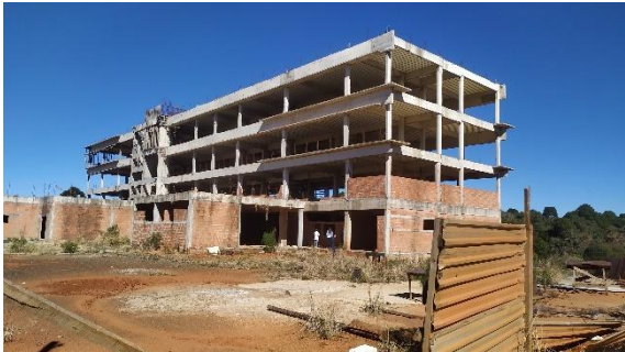
Foto 05 – Visão geral da obra
