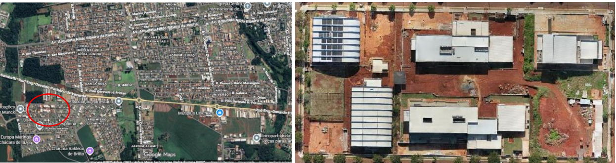
FIGURA 1 - Localização obra e foto geral da obra
